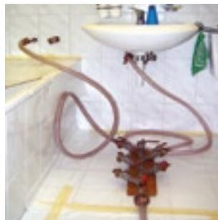
Nach der Rohr-Reini-gung erfolgt die Innenbeschichtung der Wasserleitungen mit Epoxydharz. Ohne bauliche Umtriebe und erst noch umweltfreundlich.
